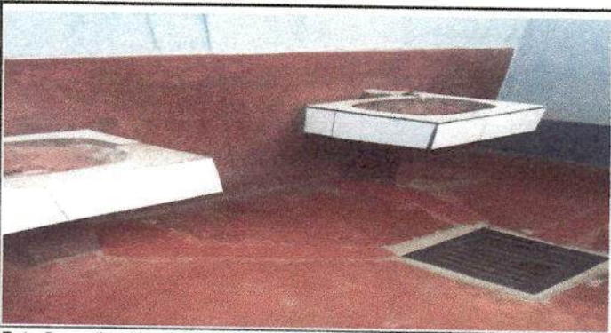
Foto 5: sustitución de lavamanos en sanitario de mujeres.
